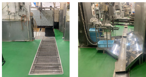
床塗装(改修) 残渣シューター設置
