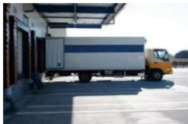
→バンニング時の機密性を確保し、コールドチェーンを確保するためのドックシェルターの整備
