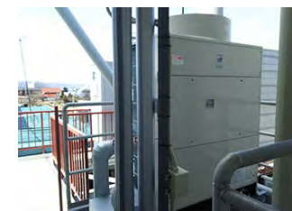
井戸水循環設備の設置（冷凍機）
