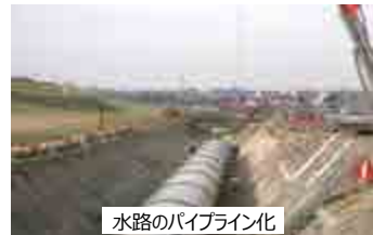
水路のパイプライン化
