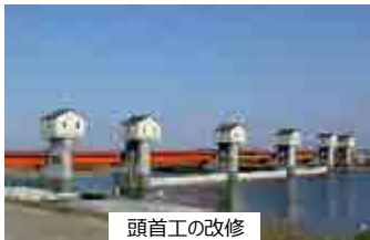
頭首工の改修
