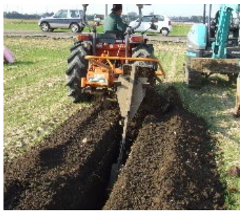
暗渠排水の整備
