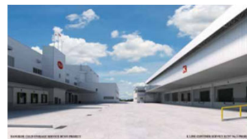
【海外の冷蔵・冷凍物流倉庫】
