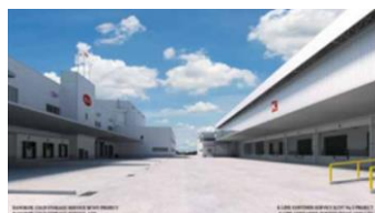
【海外の冷蔵・冷凍物流倉庫】
