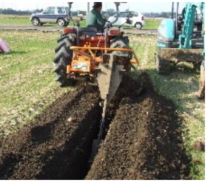
暗渠排水の整備
