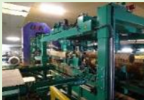
木材加工流通施設の整備
