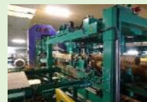
木材加工流通施設の整備
