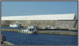
防波堤の嵩上げによる越波対策
