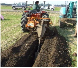
暗渠排水の整備
