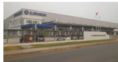
インドネシア 冷凍冷蔵倉庫整備・運営事業
