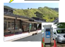
EV車等への給電設備
