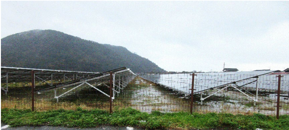
発電施設の外観
