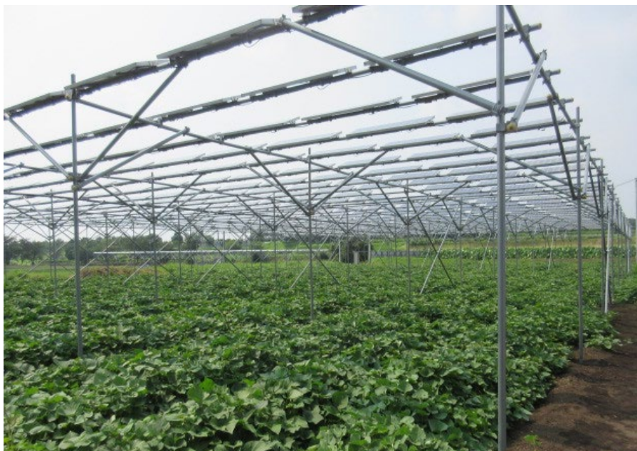
露地の畑の上部にパネルを設置
