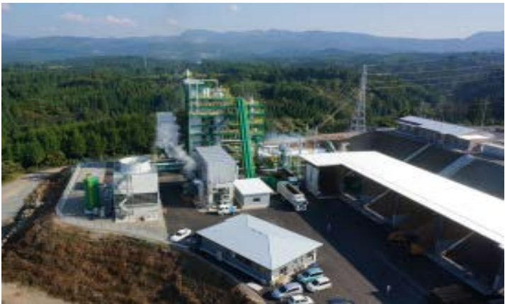
発電施設の外観
