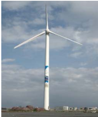
漁港内に設置された風車
