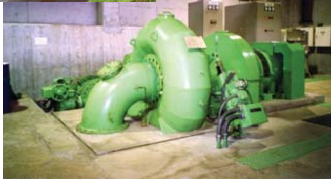
那須野ヶ原発電所 水力発電施設の外観と水車
