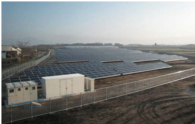
発電施設の外観
