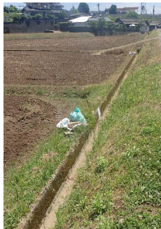
補修された水路
