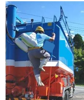
重い添加物を担ぎ バルク車を昇る作業
