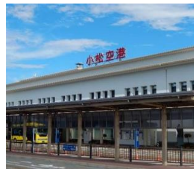
県内空港(小松)の活用実証
