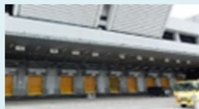
大型車に対応した トラックバース
