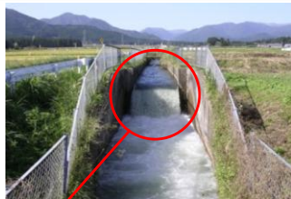
安定的な取水、及び施設の安全性確保等のため、流速を抑える目的で落差工を設け、エネルギーを減勢
