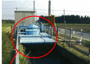
落差工に小水力発電施設を設置し、減勢させていたエネルギーを有効活用
