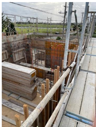
第二キッチン建設現場
