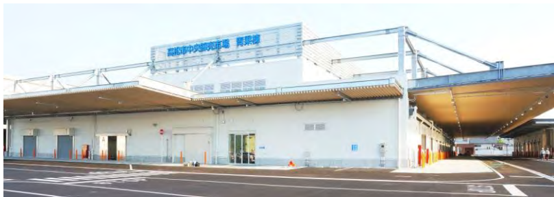
コンパクトな閉鎖型施設
