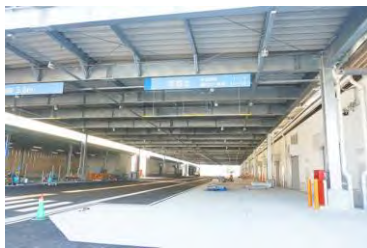
大屋根下の荷卸し場
