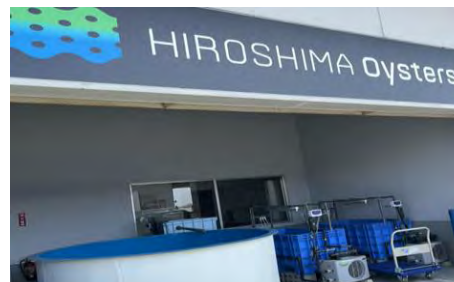
【広島空港の出荷・加工施設】
