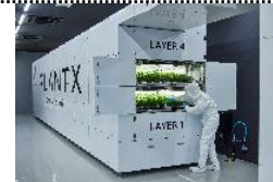
密閉型構造の植物工場
