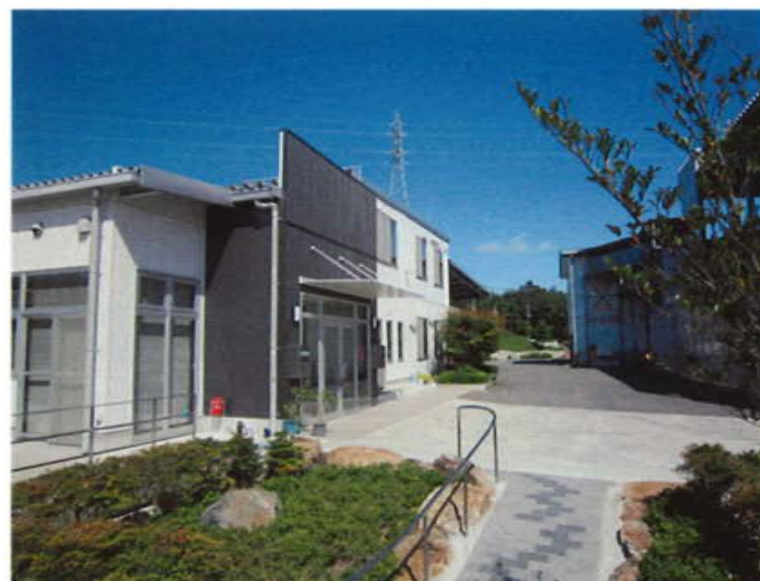
事務棟・集出荷場
