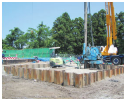
写真 立坑の施工状況
