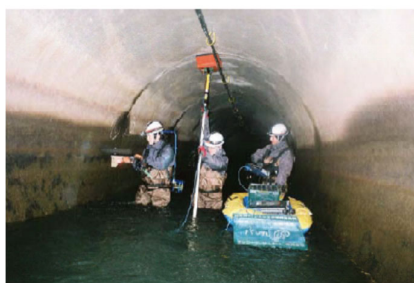
写真 事業実施前の有馬トンネル背面空洞調査の状況
