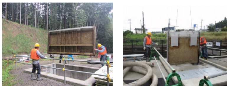
写真 有馬トンネルと併設水路の切替作業の状況（左：分流工、右：合流工）
