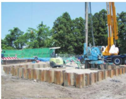
写真 立坑の施工状況
