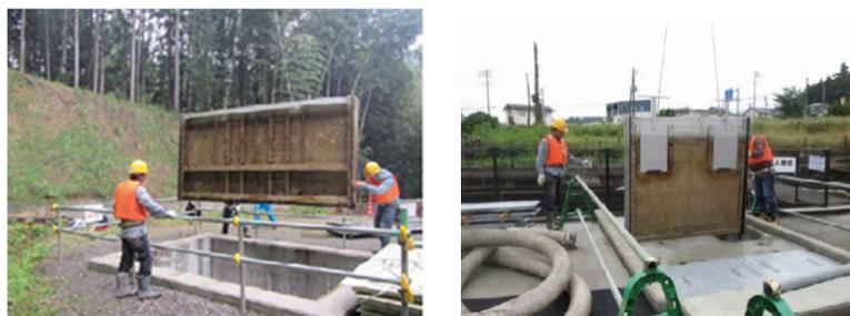
写真 有馬トンネルと併設水路の切替作業の状況（左：分流工、右：合流工）
