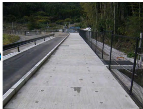
蓋かけにより周辺からのゴミ混入が減り 除塵作業の労力が軽減
