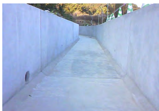
コンクリート表面被覆工法による開水路改築
