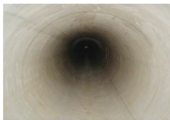
管更生工法による管水路改築
