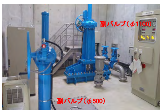
江川ダム利水放流副バルブ設置
