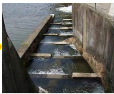
女男石頭首工 改築した魚道・二分割した洪水吐ゲート
