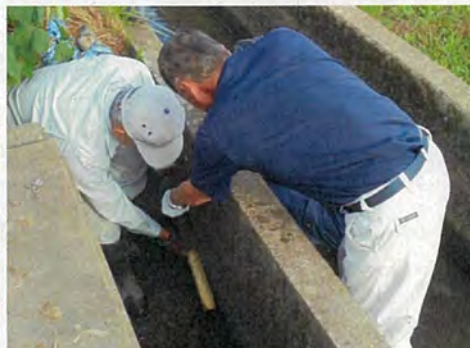
水路の目地補修作業
