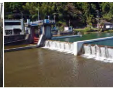
女男石頭首工 改築した魚道・二分割した洪水吐ゲート
