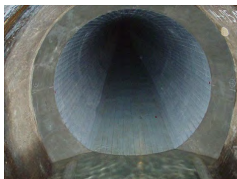
寺内導水路トンネル内面補強
