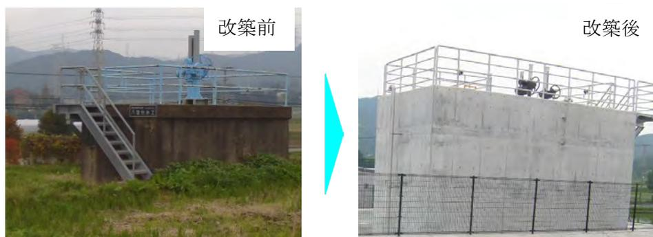
図 景観に配慮したコンクリート構造物と周辺整備（夜須支線水路八並分水工）
