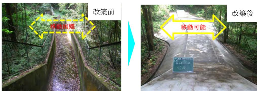
図 生物の移動に配慮した開水路の施工
