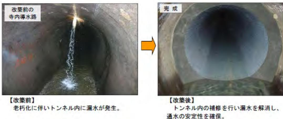
図 寺内導水路老朽化状況及び補修状況
