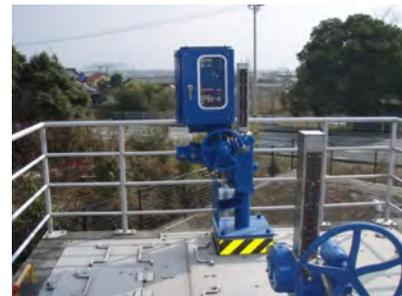
動力による分土工の遠方操作
