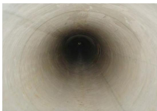
管更生工法による管水路改築
