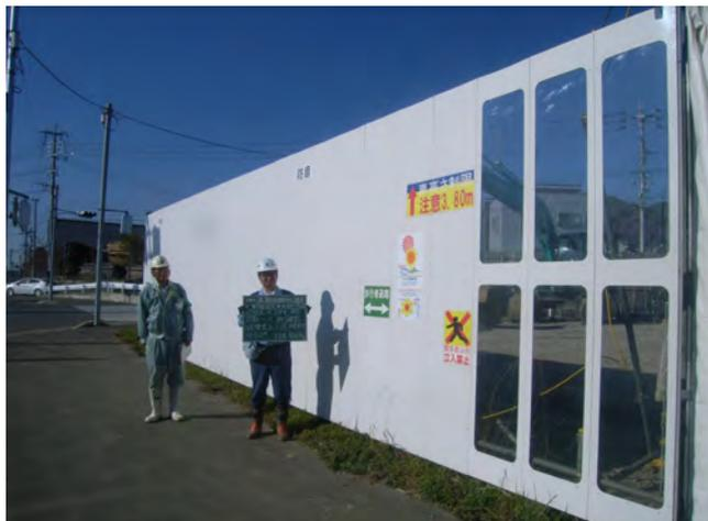
図 防音壁の設置（福田支線水路柿原3号分土工改築）
