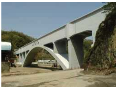
入鹿水路橋補修
