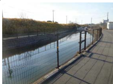
転落防止フェンス
