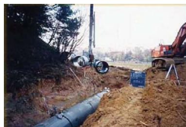
支線水路のパイプライン化
