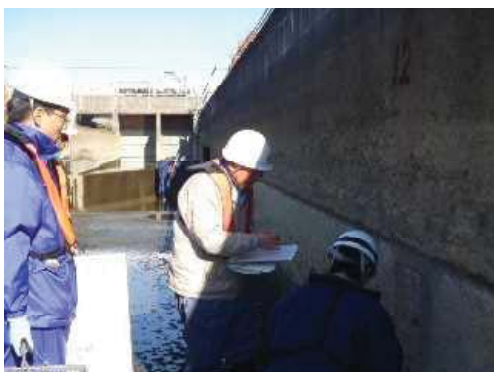
水路の施設機能点検
