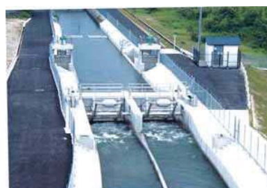
自動水位調節堰
