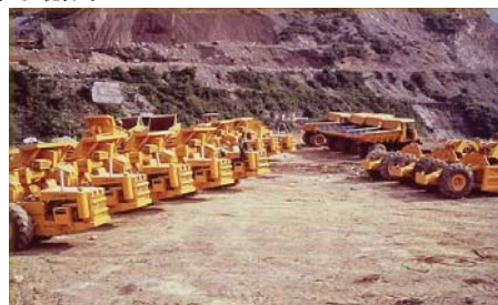
全面的な機械化施工
