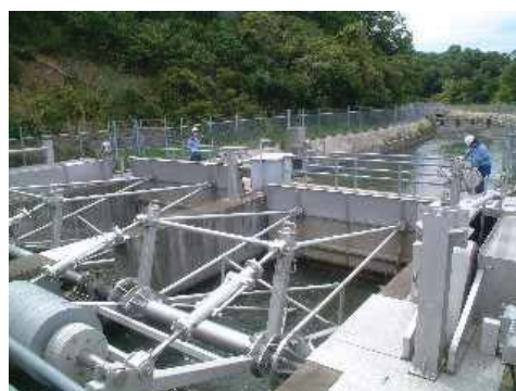
自動水位調節堰点検
