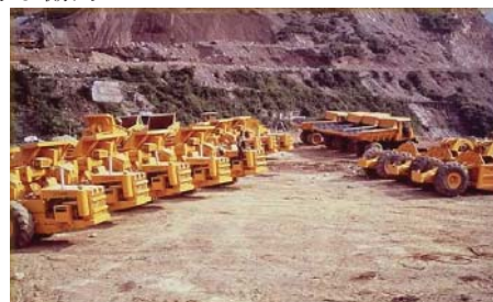
全面的な機械化施工
