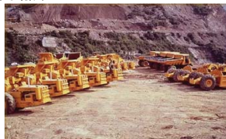
全面的な機械化施工
