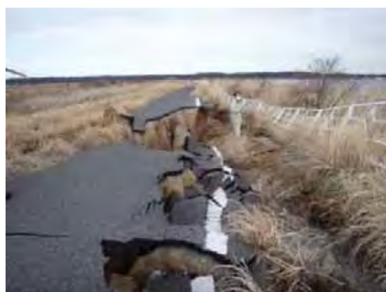
東日本大震災により被災した堤防
