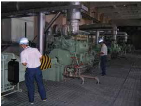
原動機（ディーゼルエンジン）の点検
