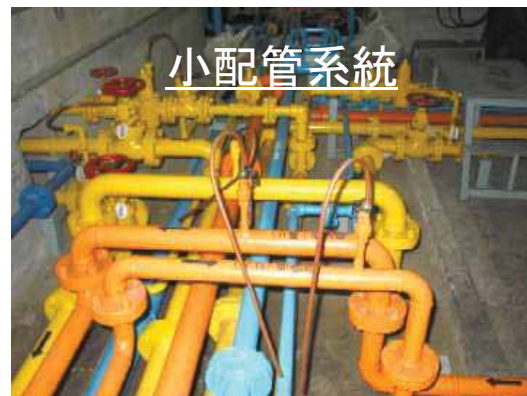
簡素化により不用となった既設系統機器設備
