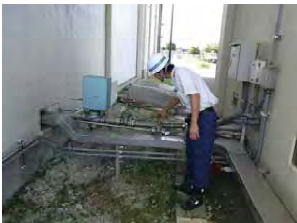
貯油槽～原動機間の燃料配管の点検
