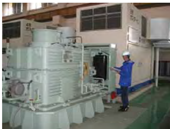
原動機（ガスタービン）の点検
