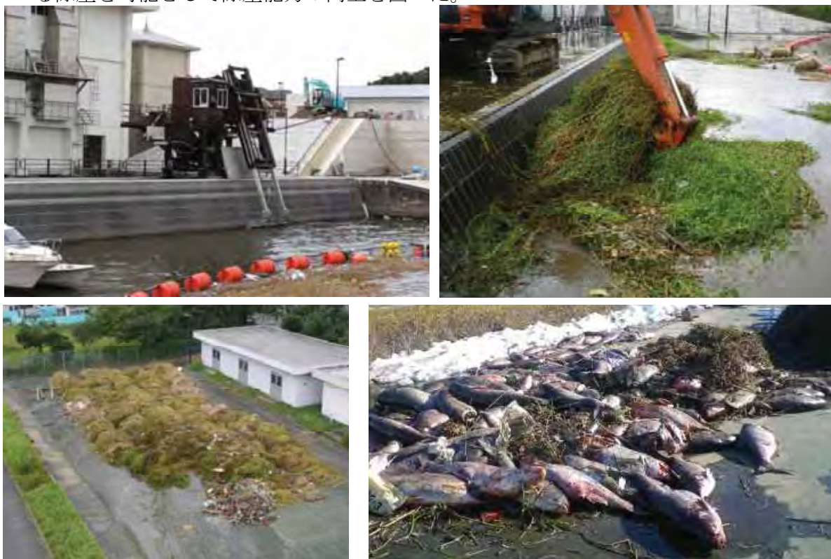
除塵機とスクリーン及びナガエツルノゲイトウ（特定外来生物）の陸揚げ作業状況【写真上】 陸揚げされたナガエツルノゲイトウと混在して陸揚げされたハクレン（淡水魚）【写真下】
