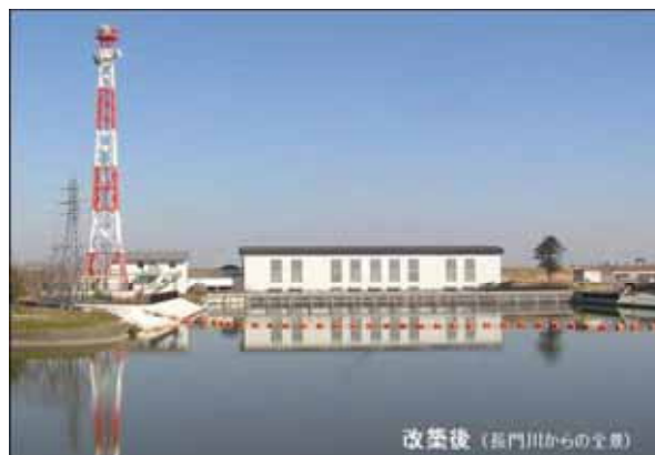
機場建屋改築 (施工後)
