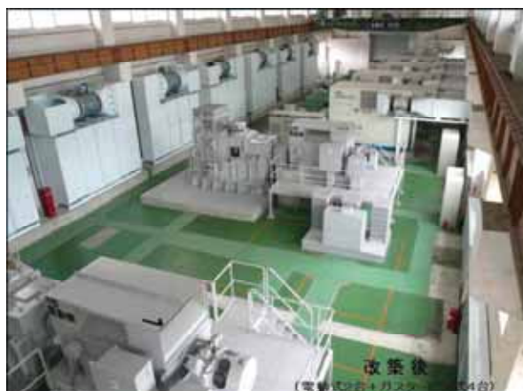
ポンプ設備改築 (施工後)
