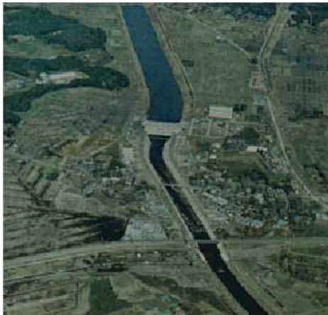
建設当時の大和田機場周辺
