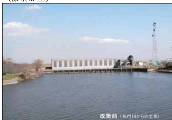
機場建屋改築 (施工前)
