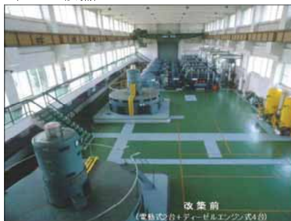
ポンプ設備改築 (施工前)
