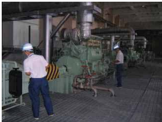
原動機（ディーゼルエンジン）の点検
