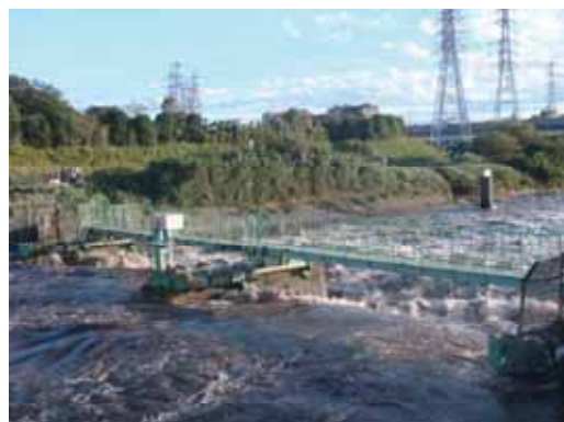
洪水排水状況（大和田機場→東京湾）
