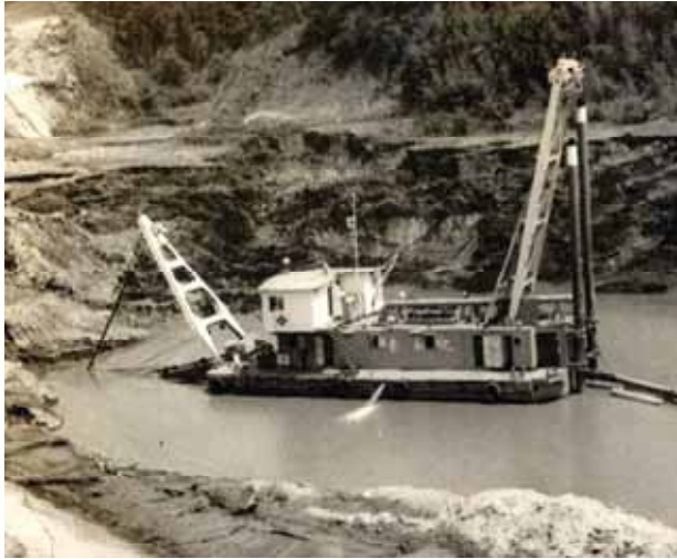
捷水路掘削（建設当時）
