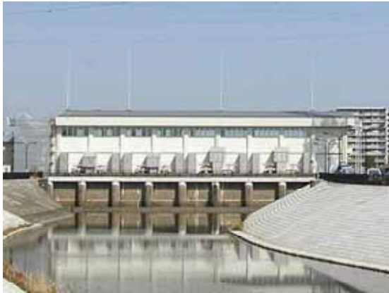
耐震補強後の大和田機場建屋
