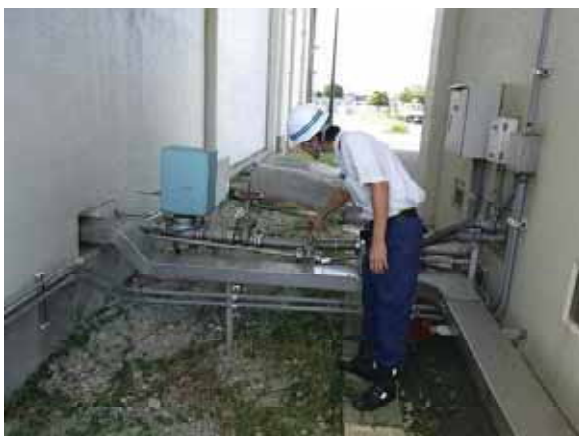
貯油槽～原動機間の燃料配管の点検
