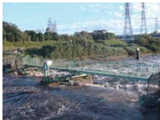
洪水排水状況（大和田機場→東京湾）
