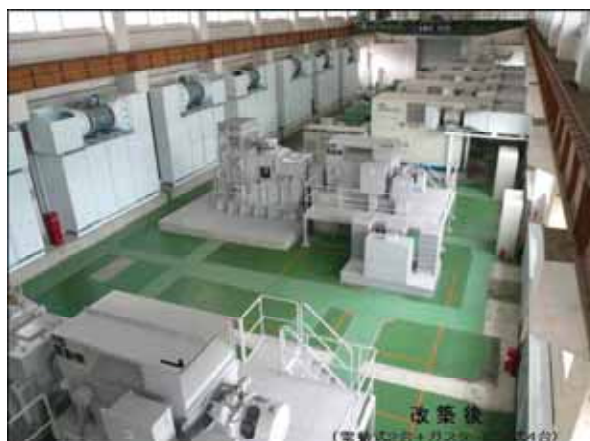
ポンプ設備改築 (施工後)
