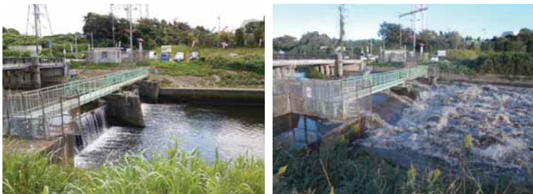
印旛疏水路（大和田機場下流）における平常時（左）と台風26号に伴う排水時（右）
