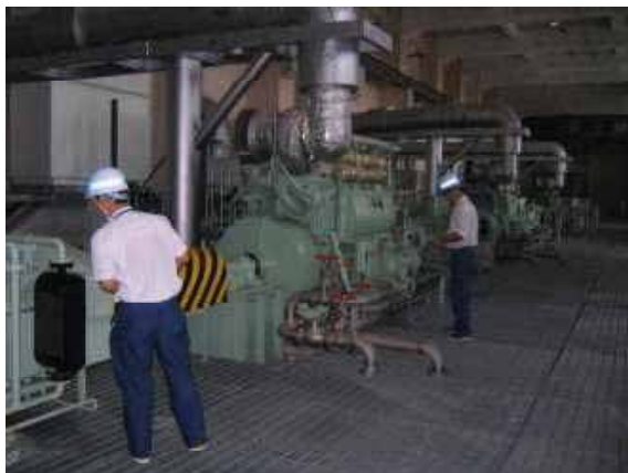
原動機（ディーゼルエンジン）の点検
