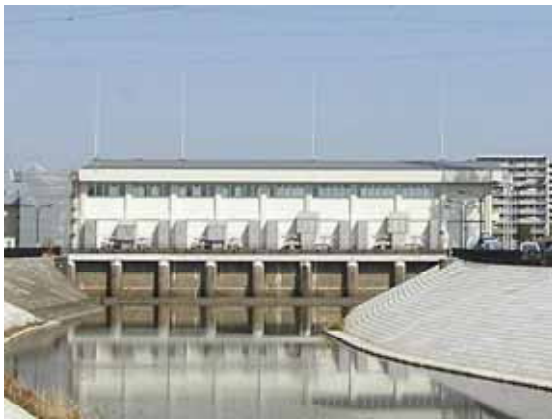
耐震補強後の大和田機場建屋
