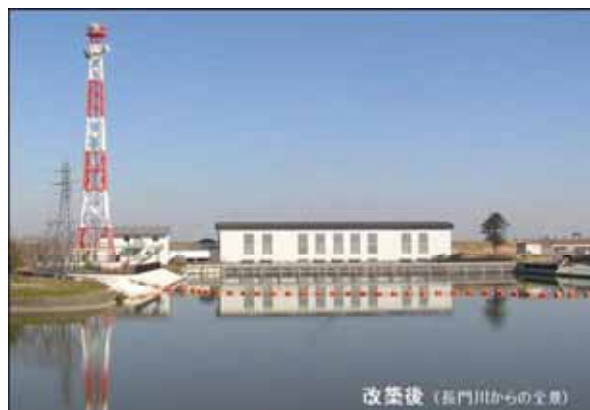
機場建屋改築 (施工後)
