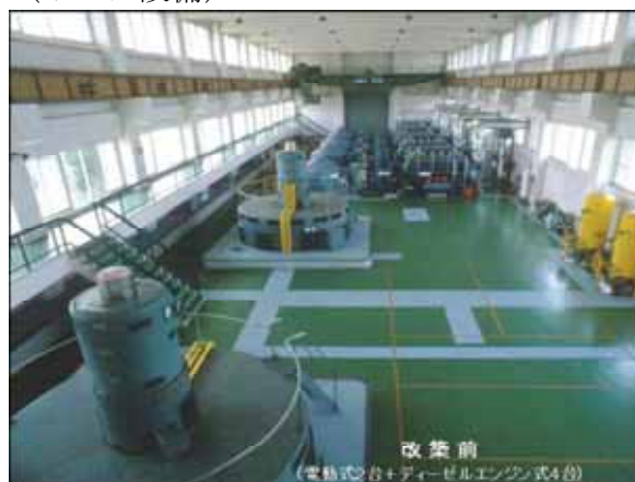
ポンプ設備改築 (施工前)
