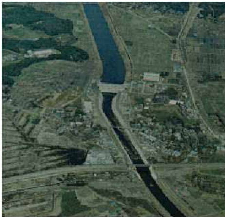
建設当時の大和田機場周辺
