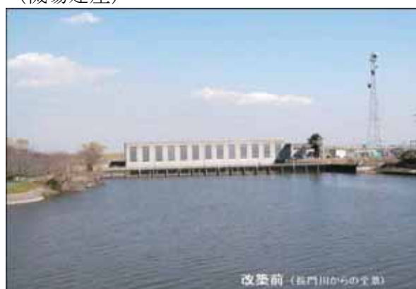
機場建屋改築 (施工前)
