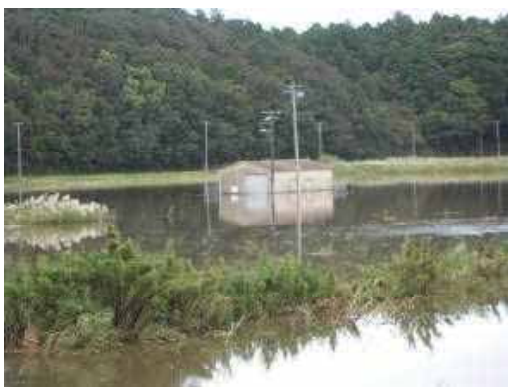
周辺農地の湛水状況
