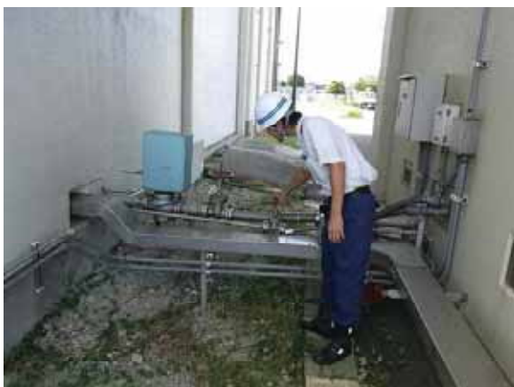
貯油槽～原動機間の燃料配管の点検
