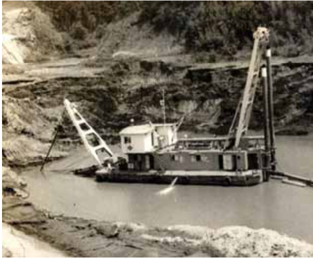
捷水路掘削（建設当時）
