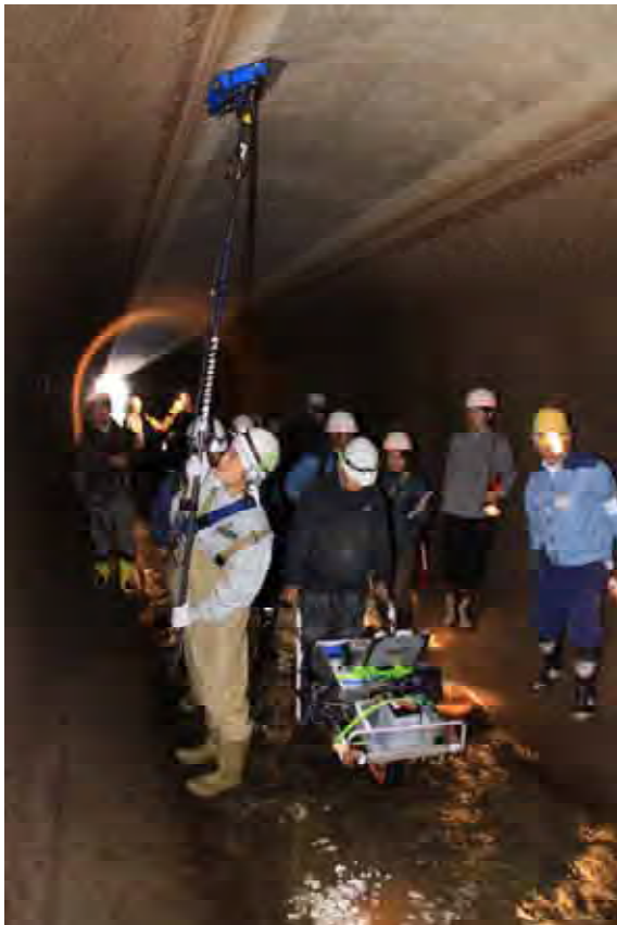
トンネル内の劣化調査
