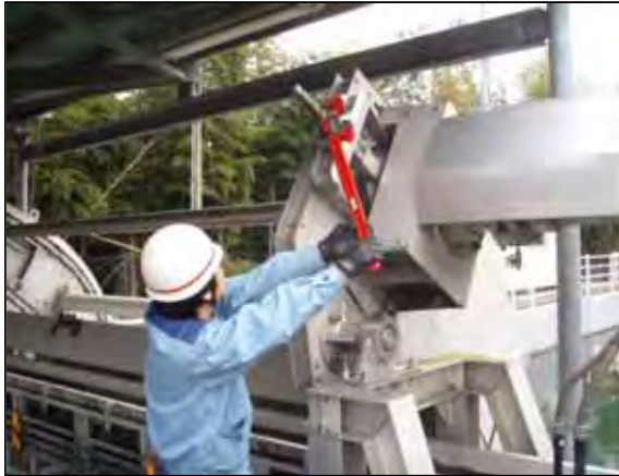
幹線水路除塵機の点検
