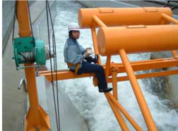
幹線水路調節堰の点検
