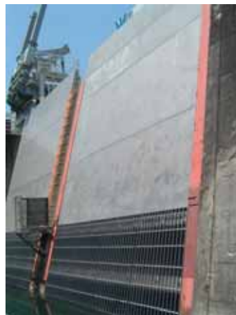
取水工除塵機の更新
