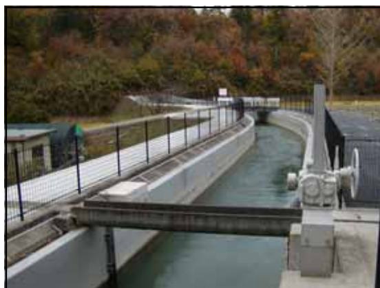
写真 用水路沿いの舗装された管理用道路（三豊市）
