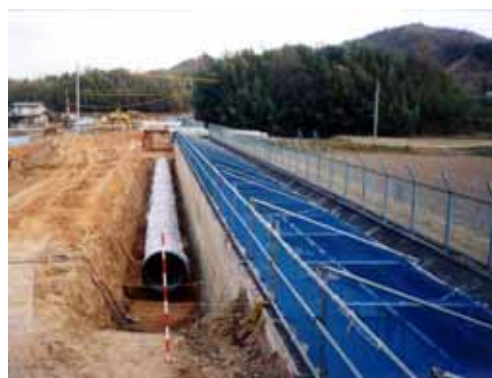
併設水路布設状況
