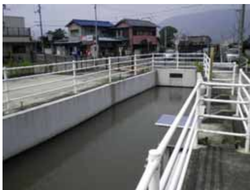
防火用水として機能する開水路
