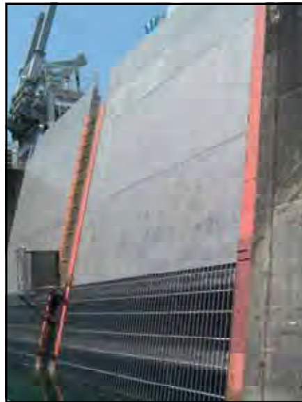
除塵施設改築（施工後）
