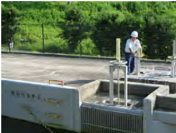
配水量に応じた分水工操作
