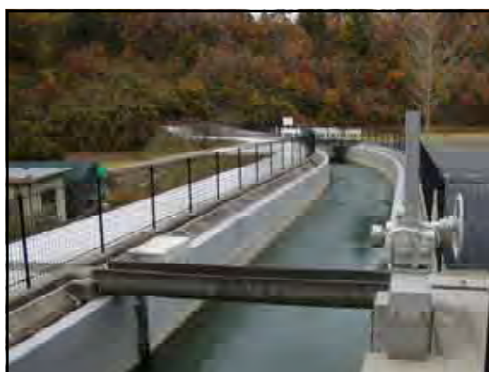
写真 用水路沿いの舗装された管理用道路（三豊市）
