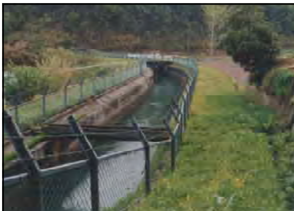
開水路改築 ( 施工前 )
