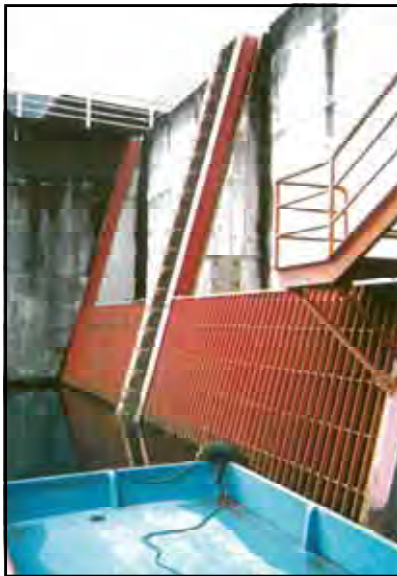
除塵施設改築（施工前）
