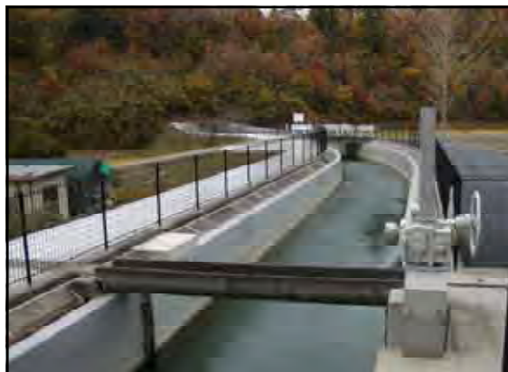
開水路改築 ( 施工後 )
