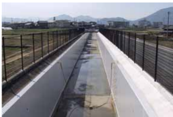
改築後（水路補強完成）
