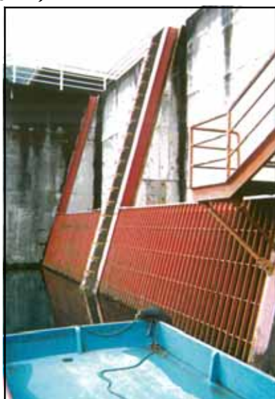
除塵施設改築（施工前）
