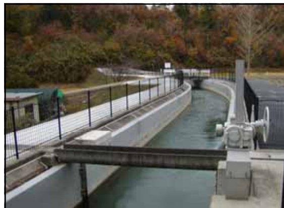
開水路改築 ( 施工後 )
