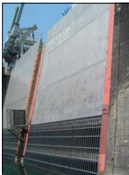
除塵施設改築（施工後）
