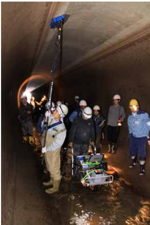
トンネル内の劣化調査
