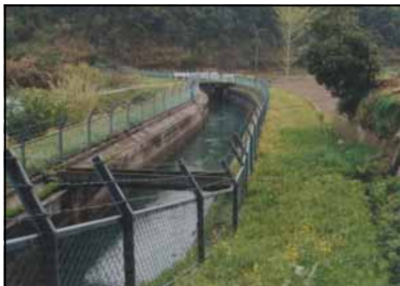
開水路改築 ( 施工前 )
