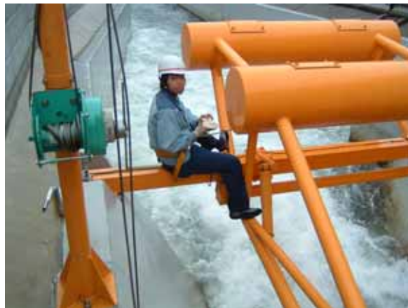
幹線水路調節堰の点検
