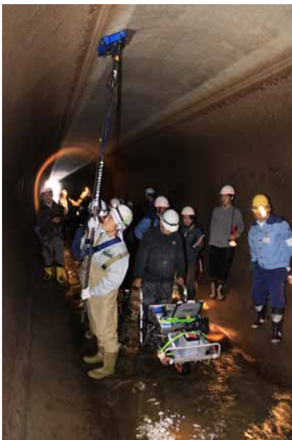
トンネル内の劣化調査
