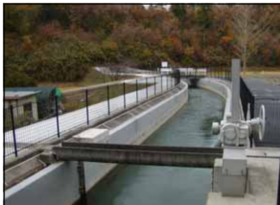
開水路改築 ( 施工後 )
