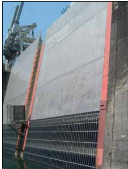
除塵施設改築（施工後）
