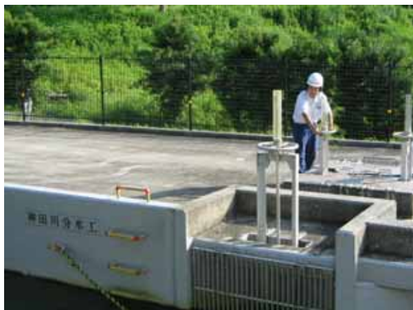
配水量に応じた分水工操作
