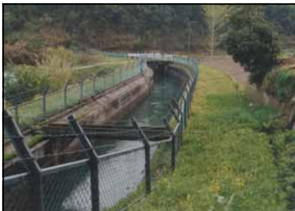
開水路改築 ( 施工前 )
