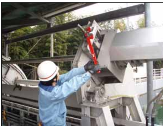
幹線水路除塵機の点検
