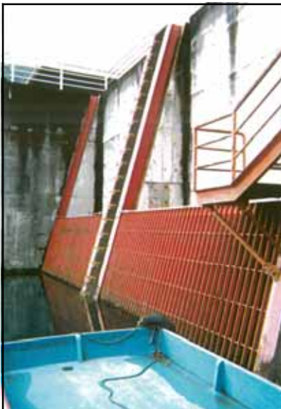
除塵施設改築（施工前）
