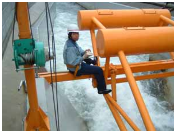
幹線水路調節堰の点検
