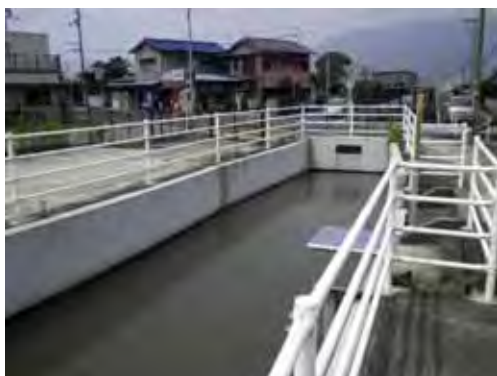
防火用水として機能する開水路 水源巡りの旅（池田ダム）
