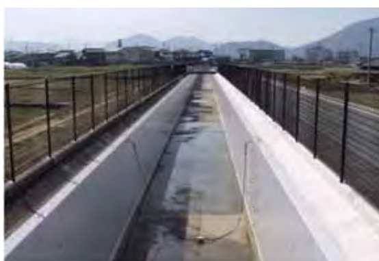
改築後（水路補強完成）
