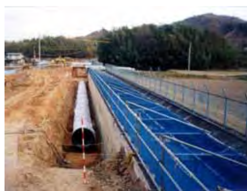
併設水路布設状況
