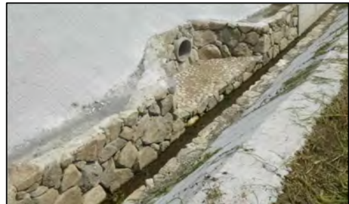
写真6.2 自然観察水路の整備
