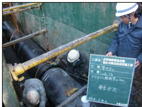
写真1.14 ダクトイル鋳鉄管 布設状況
