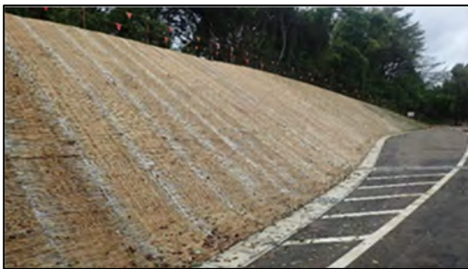
写真6.1 自然分解型植生シートの使用
