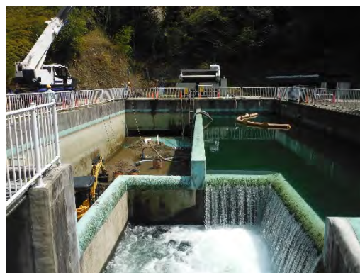
写真3.3 改築後の土砂撤去状況
