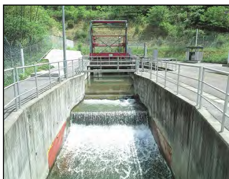
写真1.3 神淵川量水部 (改築前)
