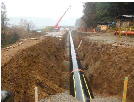
写真1.7 鋼管布設状況
