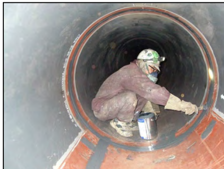
写真1.12 鋼管の溶接箇所塗装 作業状況
