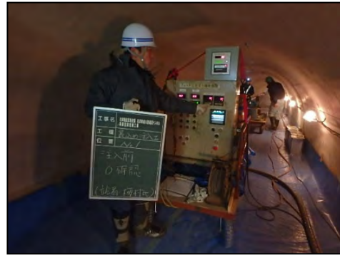
写真1.6 トンネル空洞充填工事
