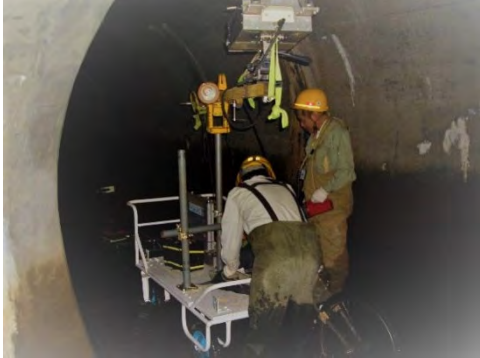
写真1.5 トンネル空洞調査
