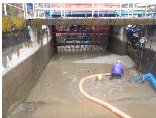
写真3.2 改築前の土砂撤去状況
