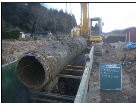
写真1.13 既設PC管の撤去
