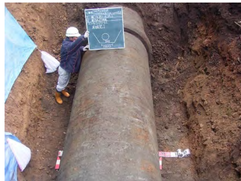
写真1.8 既設PC管の状況
