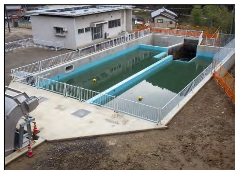
写真1.4 神淵川量水部 (改築後)
