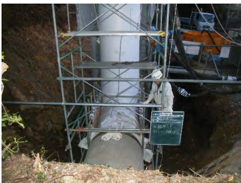
写真1.9 管更正工法施工状況
