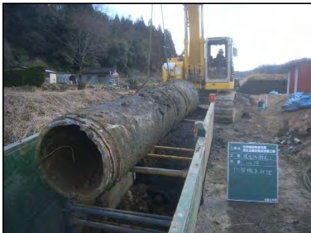
写真1.13 既設PC管の撤去
