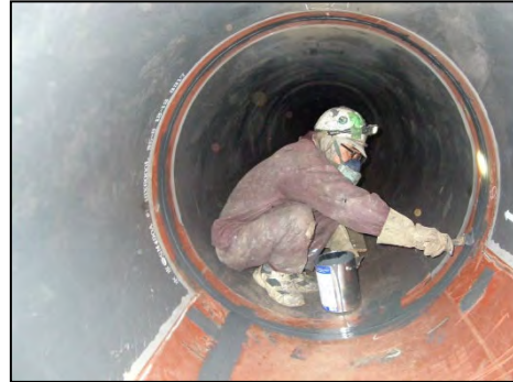
写真1.12 鋼管の溶接箇所塗装 作業状況
