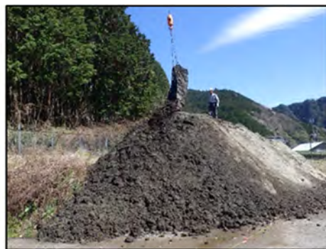
写真5.2 神湊沈砂池の土砂撤去状況
