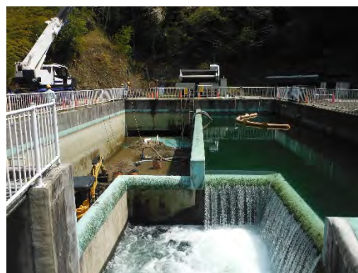
写真3.3 改築後の土砂撤去状況
