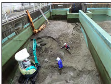
写真5.2 神湊沈砂池の土砂撤去状況
