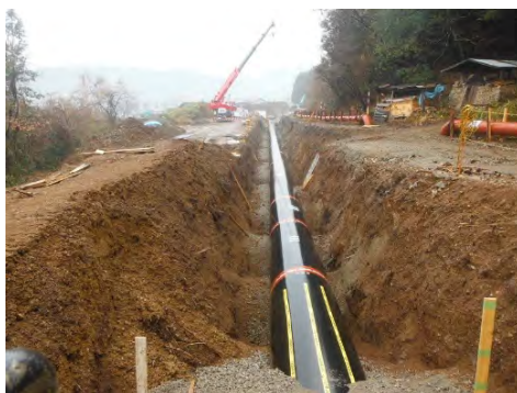
写真1.7 鋼管布設状況
