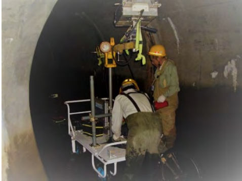
写真1.5 トンネル空洞調査
