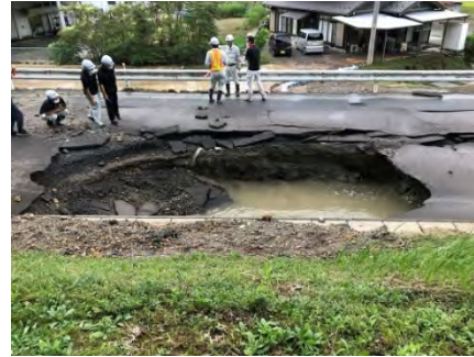
写真7.2 漏水による道路陥没状況
