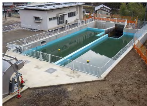
写真1.4 神湊川量水部 (改築後)
