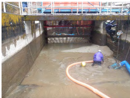
写真3.2 改築前の土砂撤去状況
