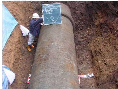
写真1.8 既設PC管の状況
