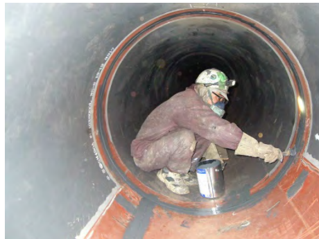
写真1.12 鋼管の溶接箇所塗装 作業状況
