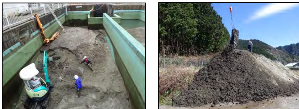
写真5.2 神漕沈砂池の土砂撤去状況
