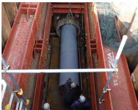
写真1.11 パイプインパイプ工法 施工状況
