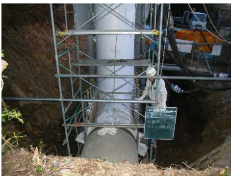
写真1.9 管更正工法施工状況
