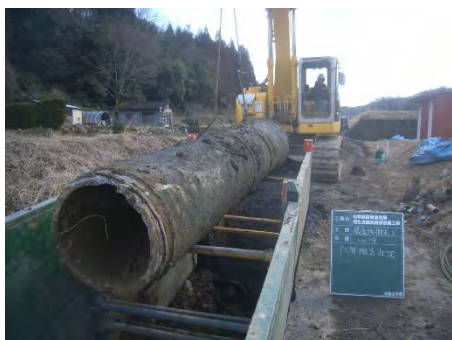
写真1.13 既設PC管の撤去
