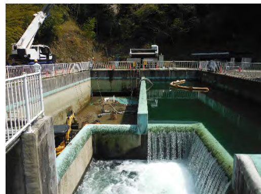
写真3.3 改築後の土砂撤去状況
