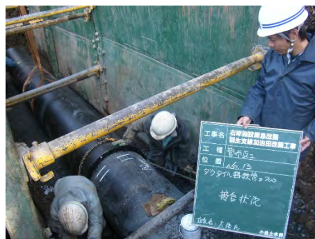
写真1.14 ダクティル鑄鉄管 布設状況
