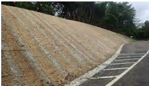
写真6.1 自然分解型植生シートの使用
