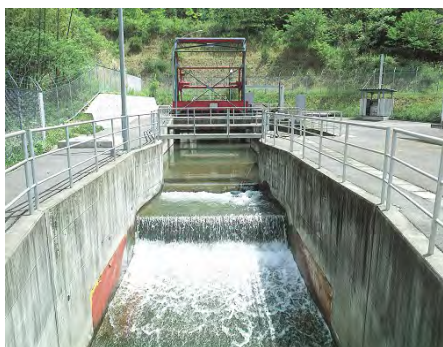
写真1.3 神湊川量水部 (改築前)
