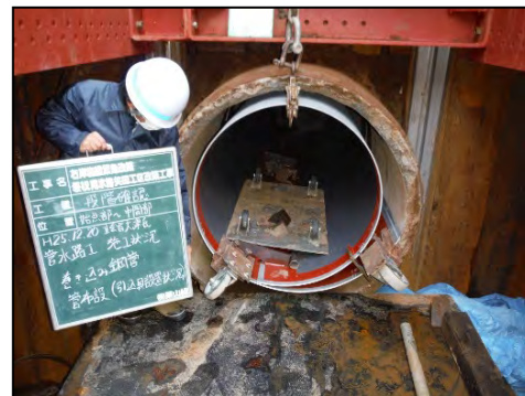
写真1.10 パイプインパイプ工法 施工状況
