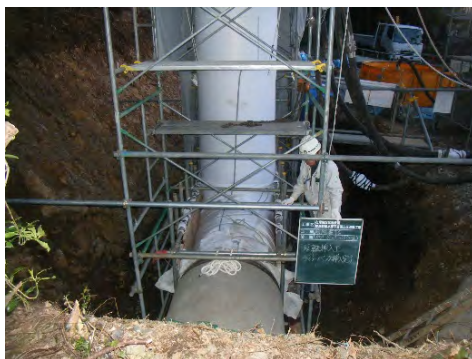
写真1.9 管更正工法施工状況
