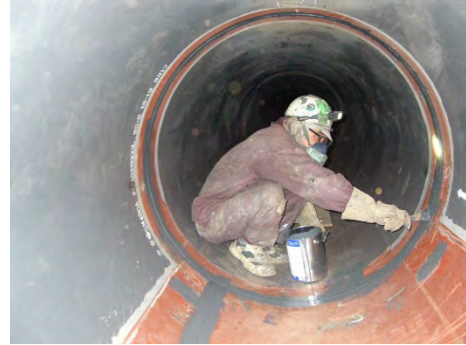
写真1.12 鋼管の溶接箇所塗装 作業状況
