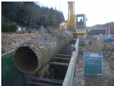
写真1.13 既設PC管の撤去
