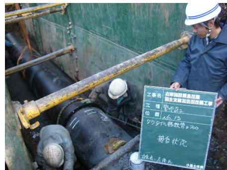
写真1.14 ダクトイル鋳鉄管 布設状況
