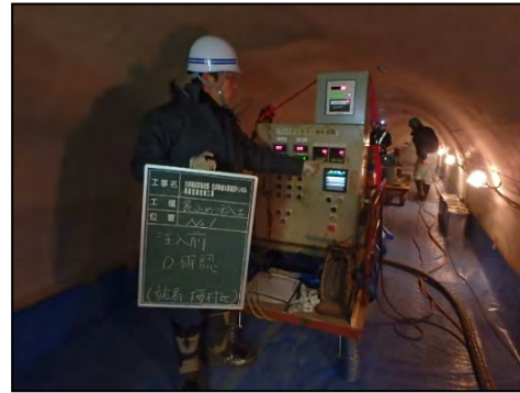
写真1.6 トンネル空洞充填工事
