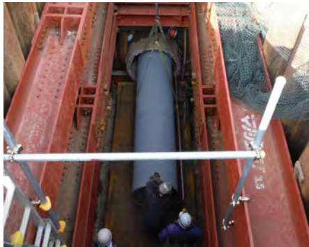
写真1.11 パイプインパイプ工法 施工状況
