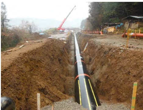
写真1.7 鋼管布設状況
