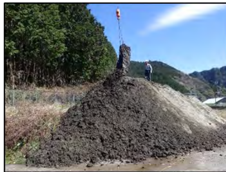
写真5.2 神漕沈砂池の土砂撤去状況
