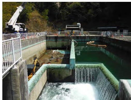
写真3.3 改築後の土砂撤去状況
