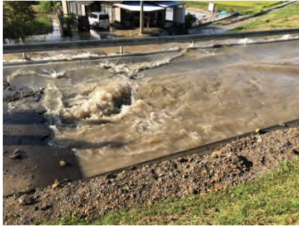
写真7.1 未改築区間での漏水状況
