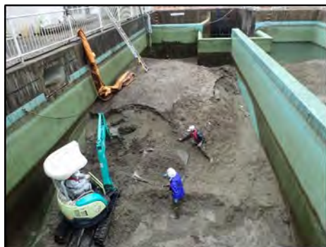
写真5.2 神漕沈砂池の土砂撤去状況
